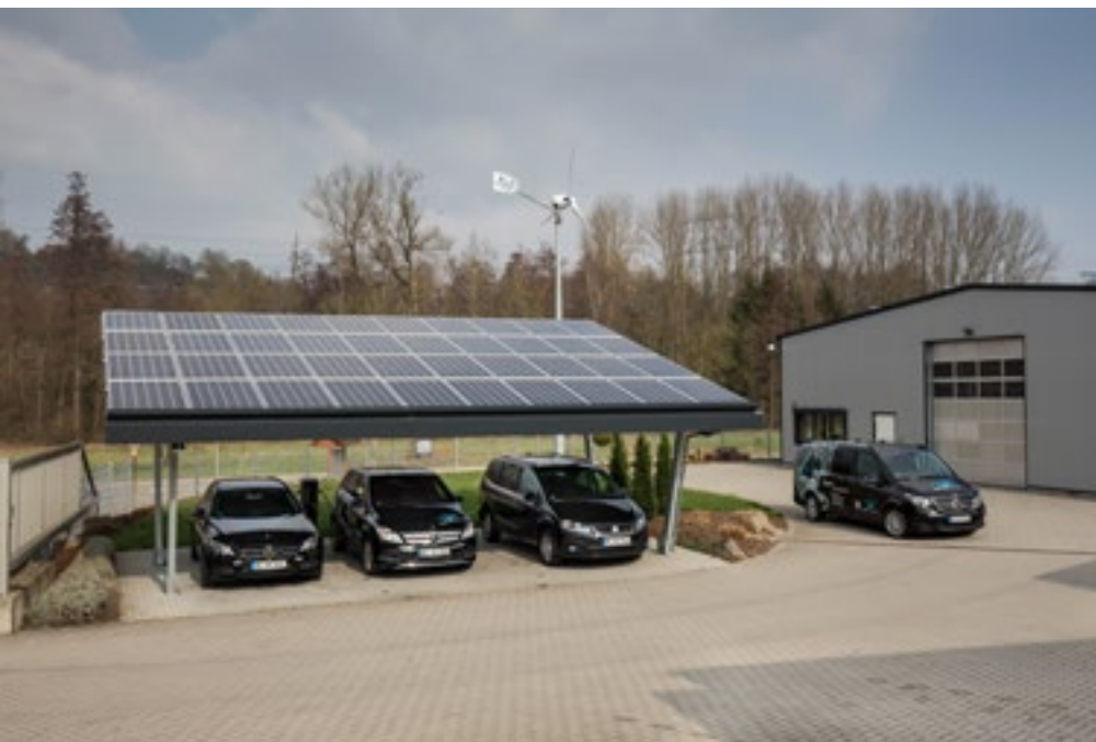
Unter dem Solar-Carport befinden sich die Ladesäulen für die E-Fahrzeuge. Bild: B&S Service
